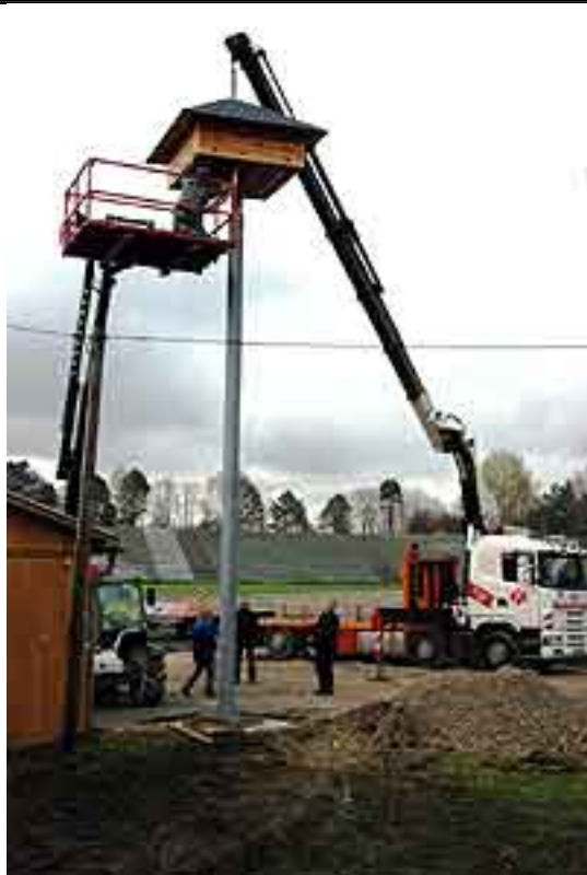
Mit einem Autokran wird der Aufsatz auf den Mast gehoben...
