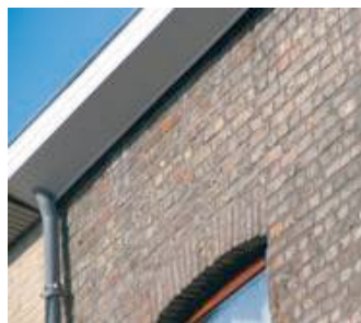
Figuur 5: Tussen de muur en de rand van de dakgoot is een spleet aanwezig waarachter gierzwaluwen nestgelegenheid kunnen vinden (bron: onbekend).
