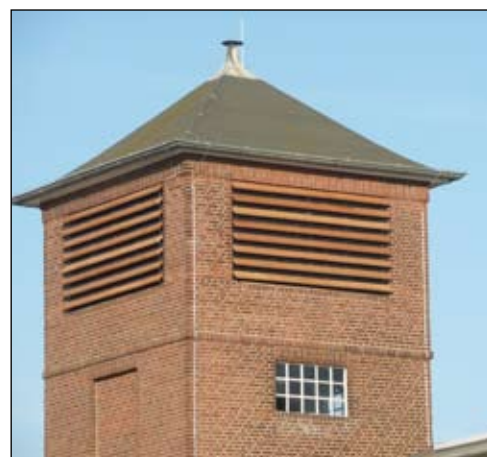
Toren van het ketelhuis
