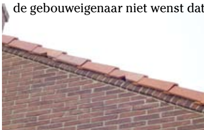
Door een driehoekje uit een kantpan te zagen, krijgt de gierzwaluw toegang tot het dakbeschoot. Bron: Fred van Vliet
